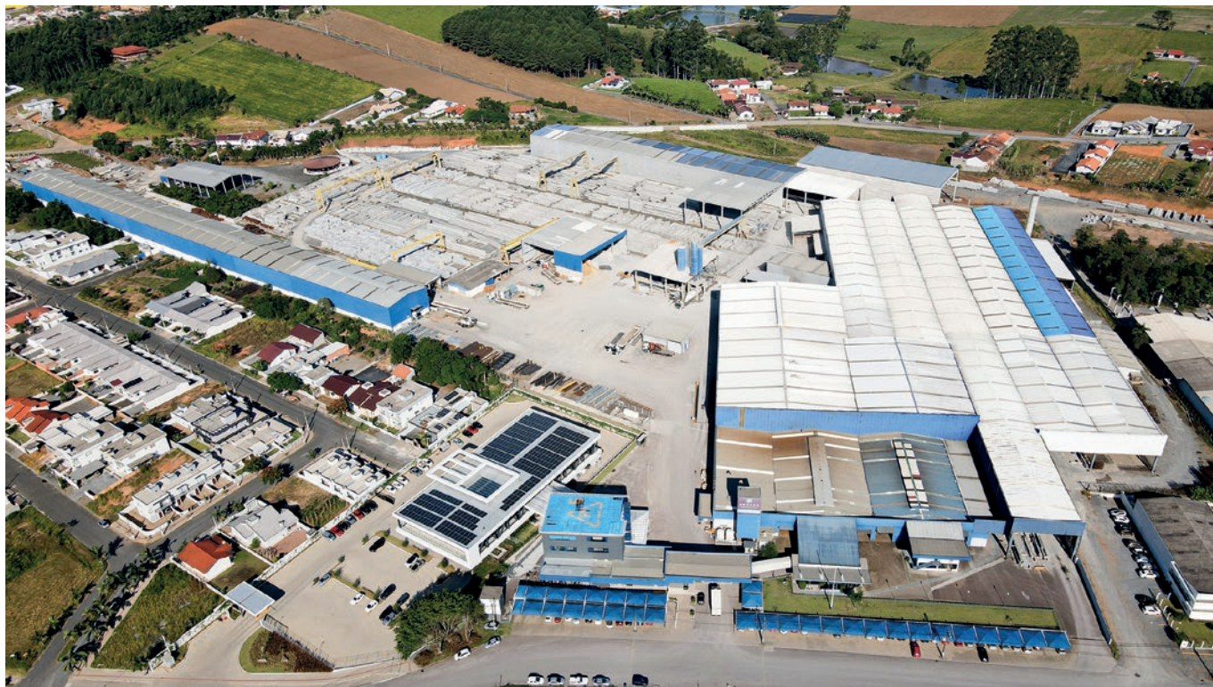
Vista aérea de la planta de producción de Proaço
